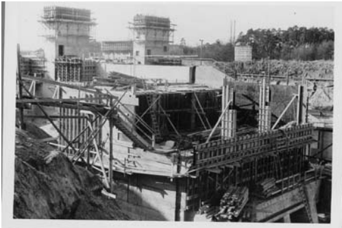
Beton- und Schalungsarbeiten
