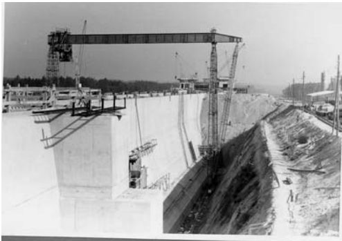
Östliche Außenwand Schleusenammer
