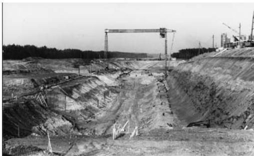
Aushub am Oberhaupt 1968
