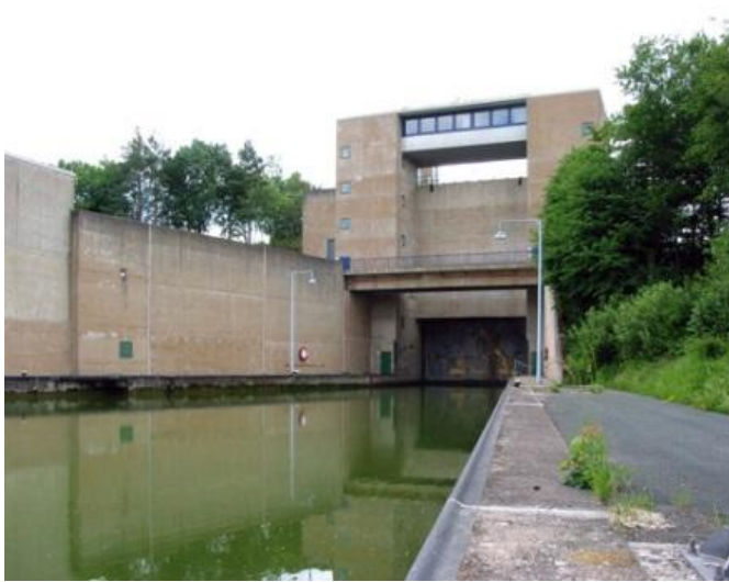
Die alte Schleuse Erlangen
